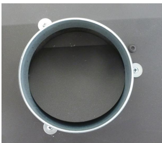
Figura n°8 - Tobera correctamente atornillada en los 3 puntos con sus arandelas
