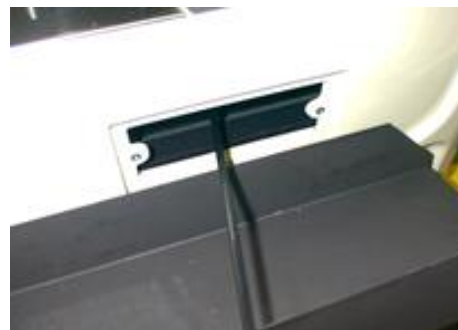
Figura n°19 - Accesos para la limpieza de la salida de humos.
